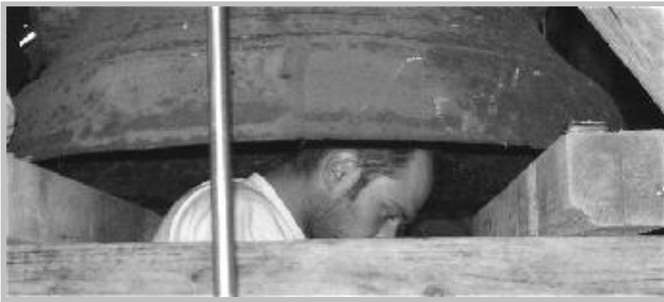
Gut behütet, aber nicht ganz ungefährlich – Reparaturen an der Glocke
